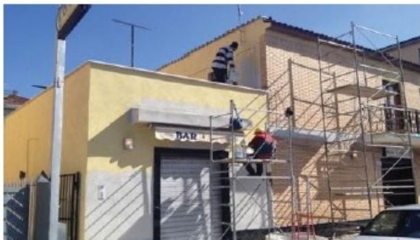
Tinteggiature e manutenzioni su facciate, tetti e superfici in quota
