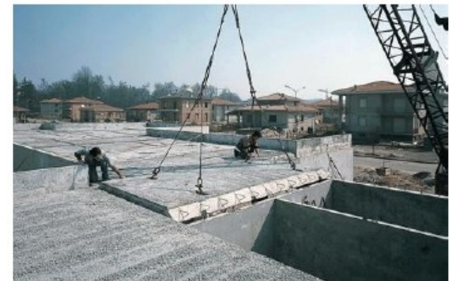
Costruzione strutture prefabbricate o nuove costruzioni edilizie
