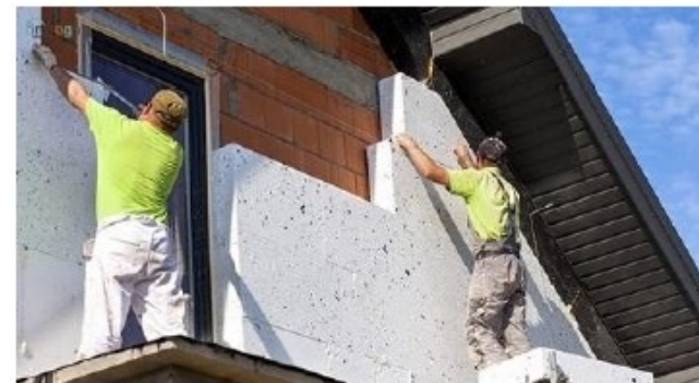
Realizzazione di cappotto termico, rasatura e realizzazione intonaco
