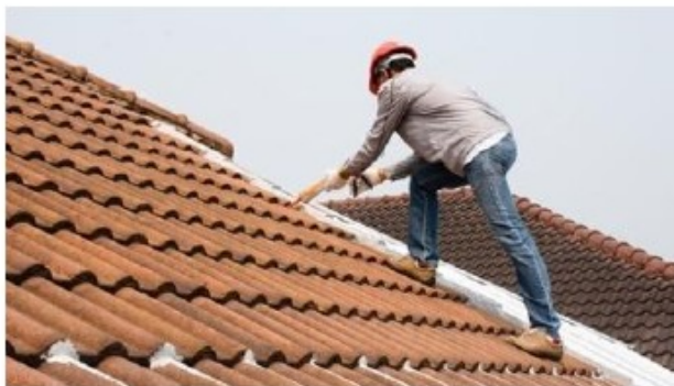
Costruzione/manutenzione tetti e superfici in quota
