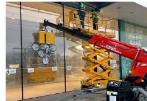
Sostituzione o montaggio serramenti
