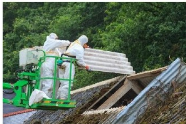
Rimozione, manutenzione e controllo delle coperture in cemento amianto
