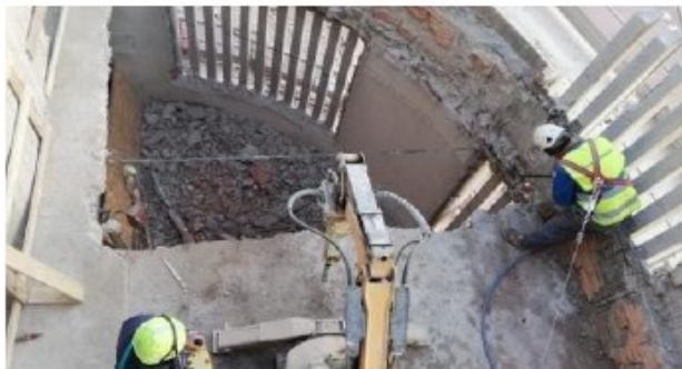
Demolizioni di edifici o solai
